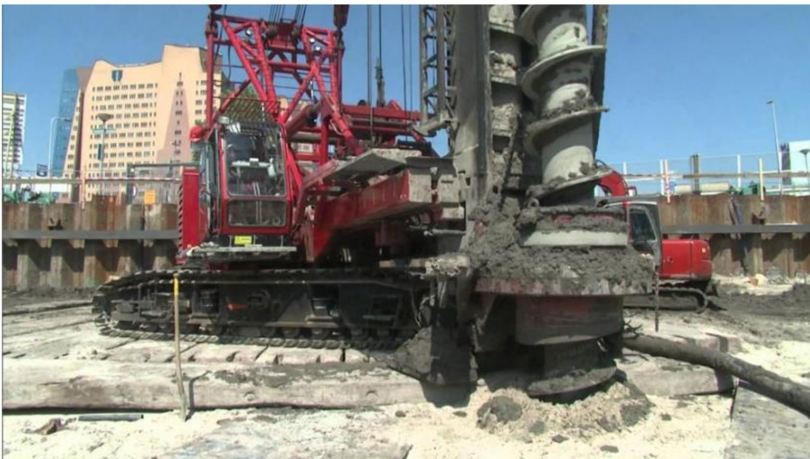
Voorbeeld van boorinstallatie voor schroefpalen
