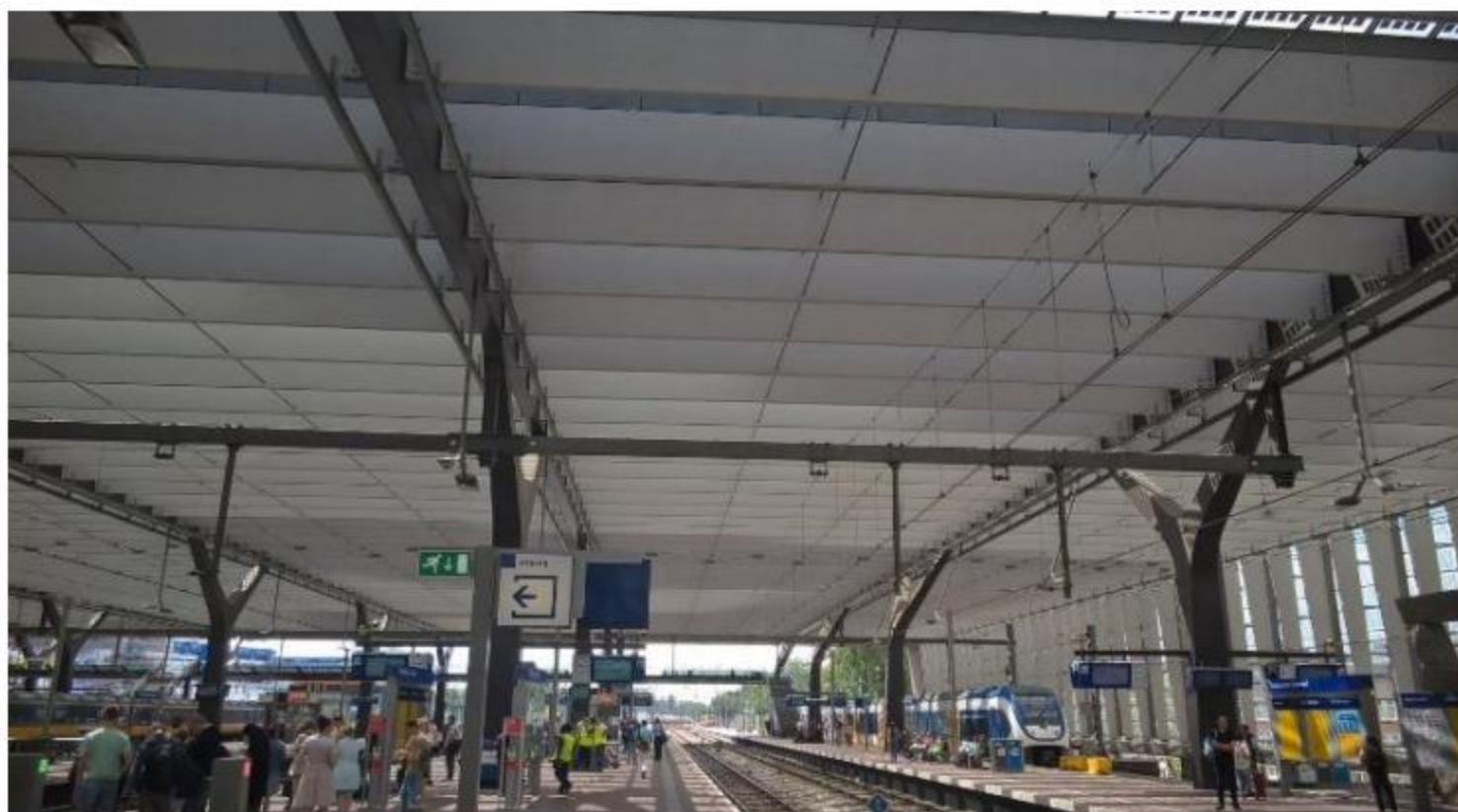
Het schitterende plafond van 2 zijde gezien, door licht inval een mooi reliëf.
