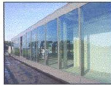
Kantoor "DIT" Oud Gastel
